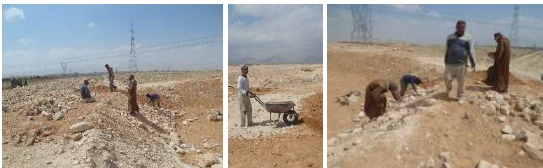
Kweekvijver voor vissen: het aanbrengen van rotsstenen en zand.
